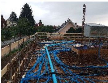
Neubau 2 EFH Sunnhaldenstrasse Dübendorf 2017
