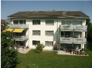
Sanierung Nasszellen MFH Fällandenstrasse Dübendorf 7 Wohnungen 2017
